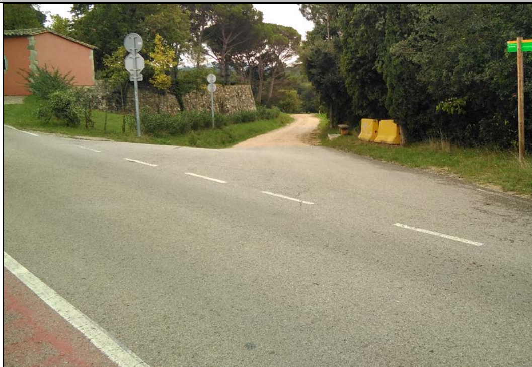
Vial d'entrada i sortida controlat i lloc d'instal·lació nova columna
